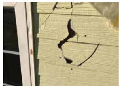
例：台風による飛来物でのサイディング破損
